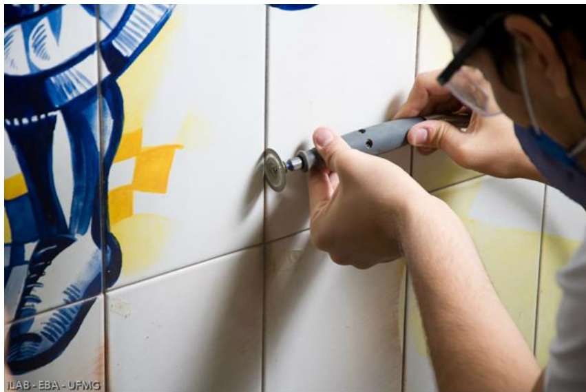
Figura 01: Remoção do Rejunte com disco Dremel SC 545. Fotografia Alexandre Leão 2012.
