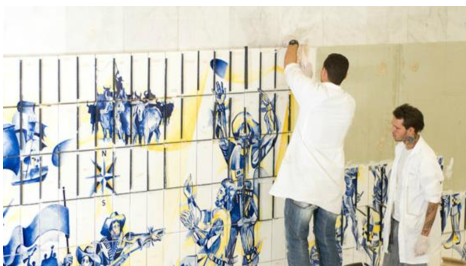
Figura 4: Assentamentos dos azulejos. Fotografia Alexandre Leão 2012.
